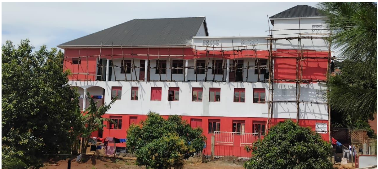
Februar 2026: Das Dachgeschoß ist fertig.
