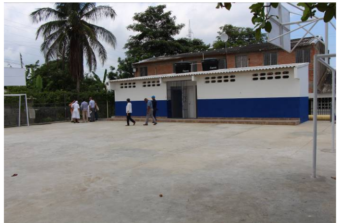
Die neuen Toilettenanlagen
